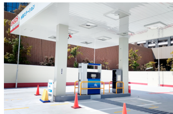
東京晴海水素ステーション
